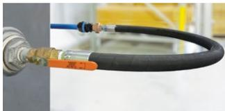
Idéalement un tuyau haute température au début du réseau permet de réduire la vibration et la chaleur produites par le compresseur.
